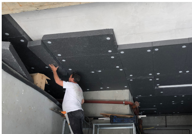
Isolation d'un garage
