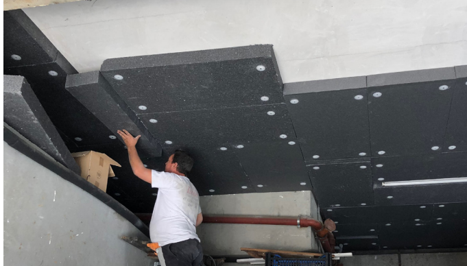
Isolation d'un garage
