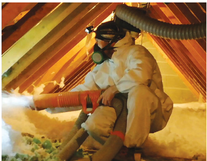
Isolation de combles
