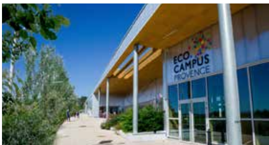
Éco-Campus Provence Formation à Sainte-Tulle
